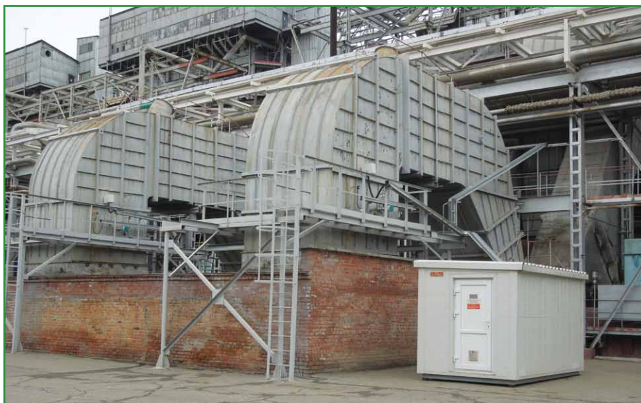
Внешний и внутренний вид системы непрерывного контроля газовых выбросов (рядом с местом отбора устанавливается контейнер, в котором размещены средства измерения)
