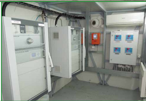
Внешний и внутренний вид системы непрерывного контроля газовых выбросов (рядом с местом отбора устанавливается контейнер, в котором размещены средства измерения)
